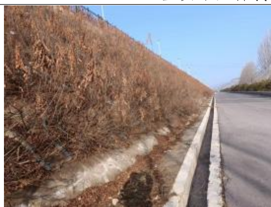
进场道路区排水沟
